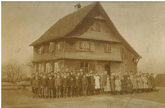
Die alte Schule kurz vor dem Abriss um 1912. Die neue Schule konnte erst 1917 fertiggestellt werden. GA Bildstein
