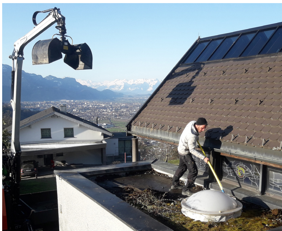
Die Flachdachsanieierung wurde professionell durchgeführt.
