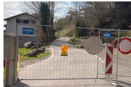
Kurzfristige Sperre erforderlich!
